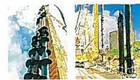
三輪削孔工事の様子
