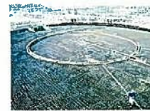
ファームポンド床版(施行)
