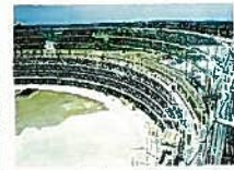
ファームポンド側壁(施行)
