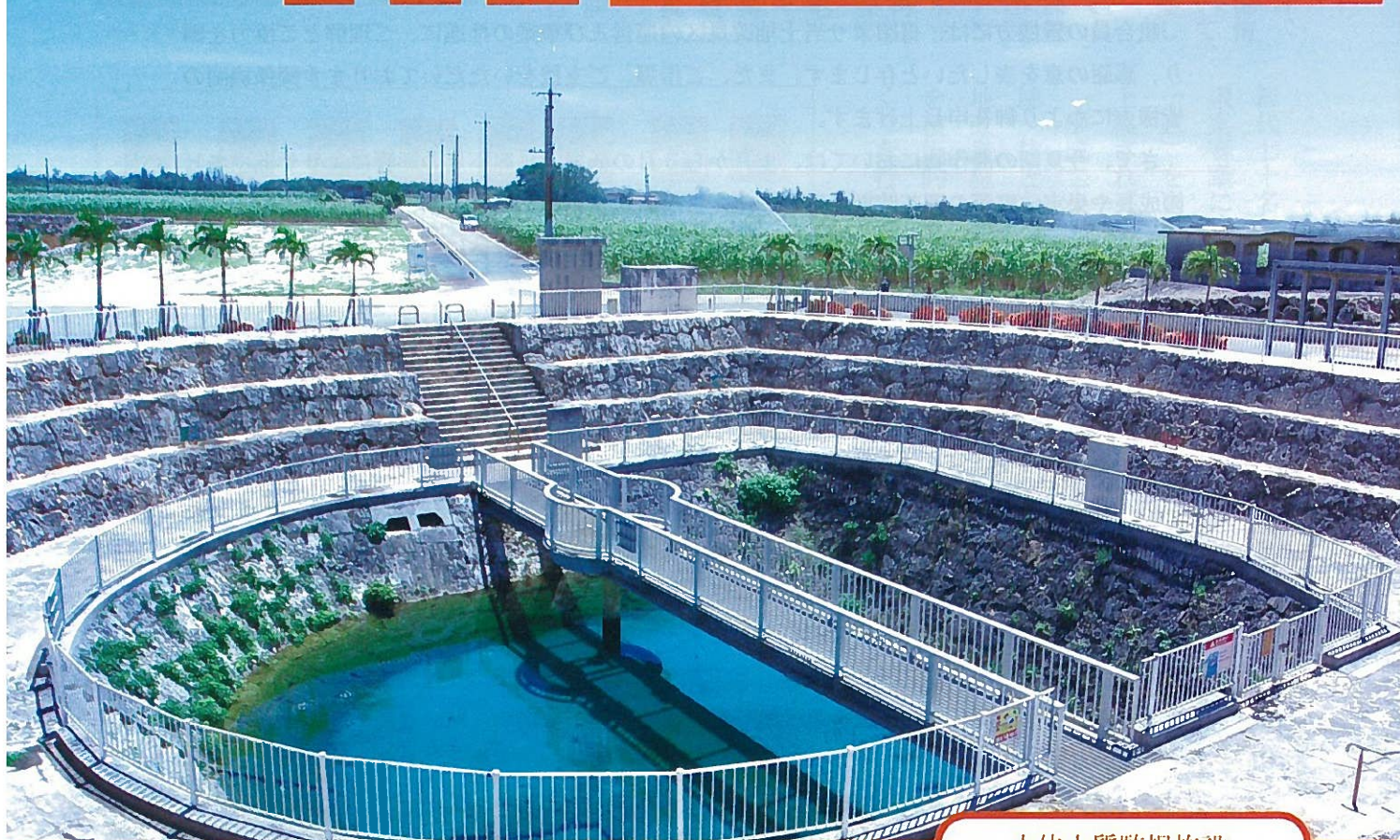
水位水質監視施設
