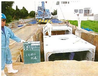
弁室設置状況
