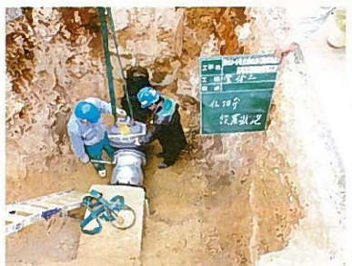
ダクタイル管布設状況
