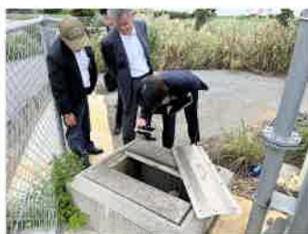
▲ 牧山給水所（伊良部）
